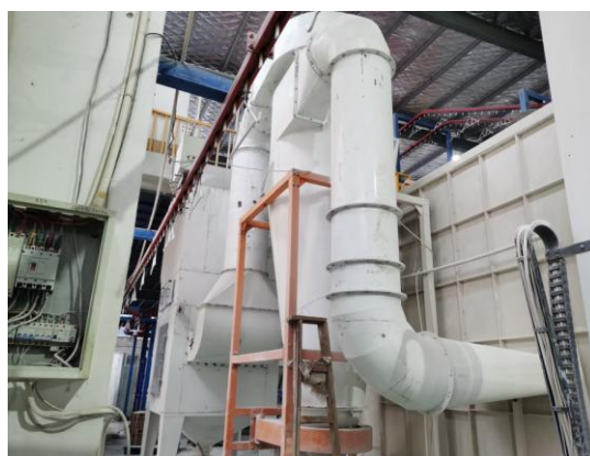
喷塑废气 TA002 (旋风+滤芯除尘系统)
