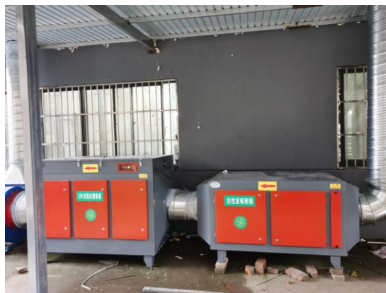
固化胶合废气 TA001 (UV 光氧+活性炭吸附装置)
