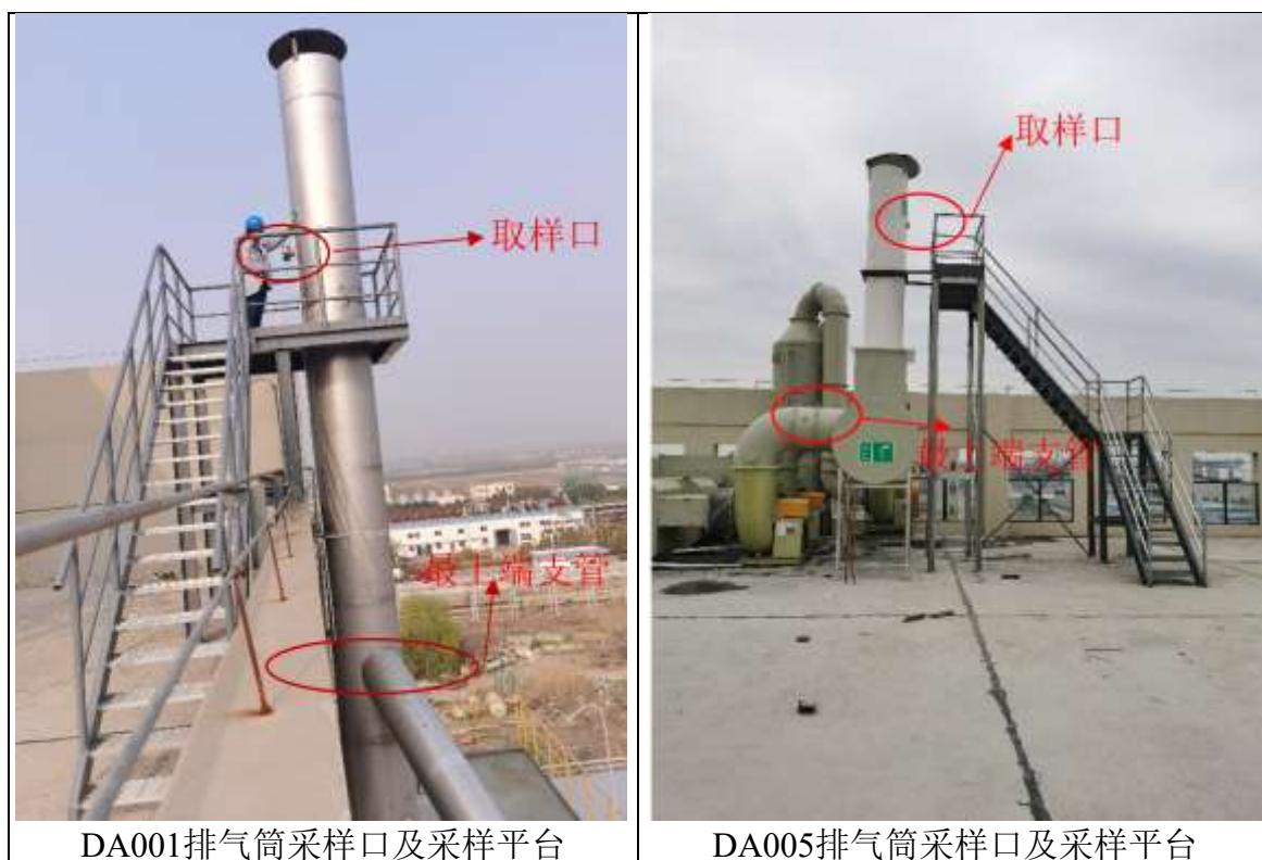
图4.2-4 采样口及采样平台规范化设置情况
