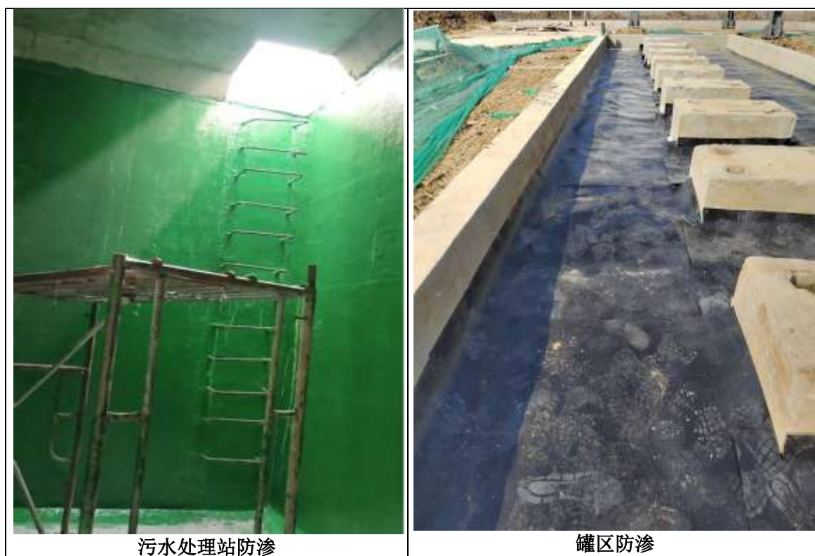
图4.2-1 防渗施工过程
