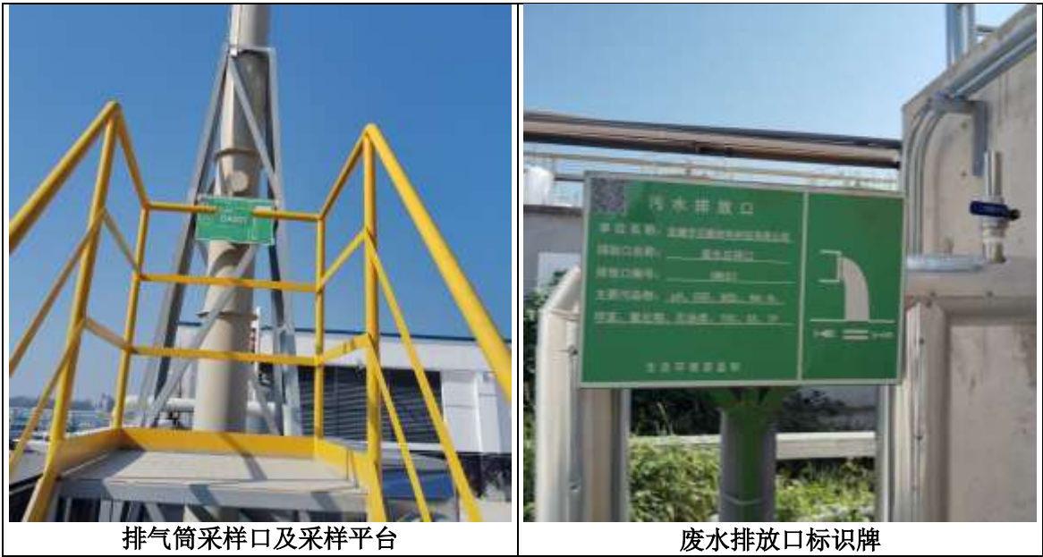
图4.2-4 排放口标识牌、采样口及采样平台规范化设置情况
