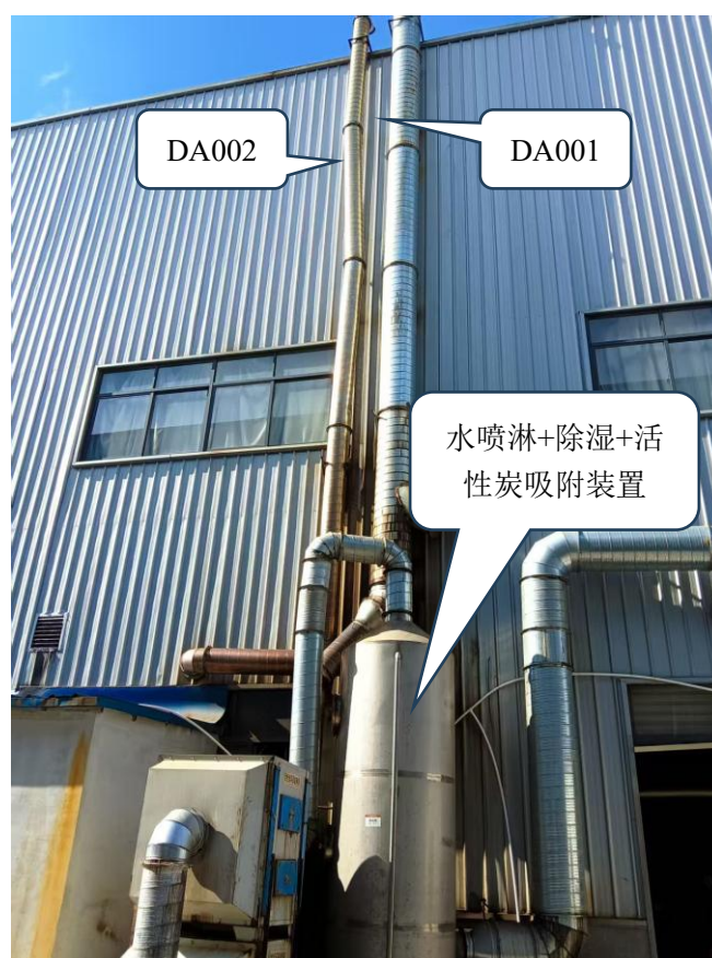
图 3-2 废气治理设施及排气筒
