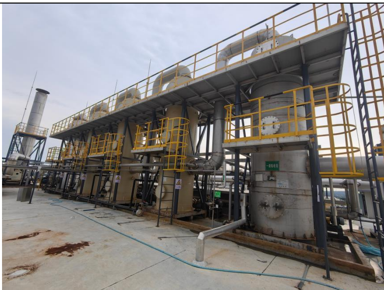
一级水吸收+两级稀硫酸吸收+一级水吸收+冷冻水吸收 (TA001-1)
