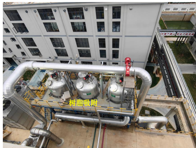
两级水喷淋吸收+两级循环水冷凝（自带）/一级水吸收（自带）+三级稀硫酸吸收+一级冷冻水冷凝+树脂吸附（TA003）
