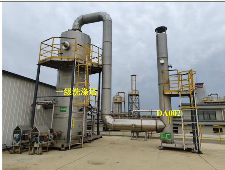
自带布袋除尘器+一级洗涤塔 (TA005)、DA002 排气筒
