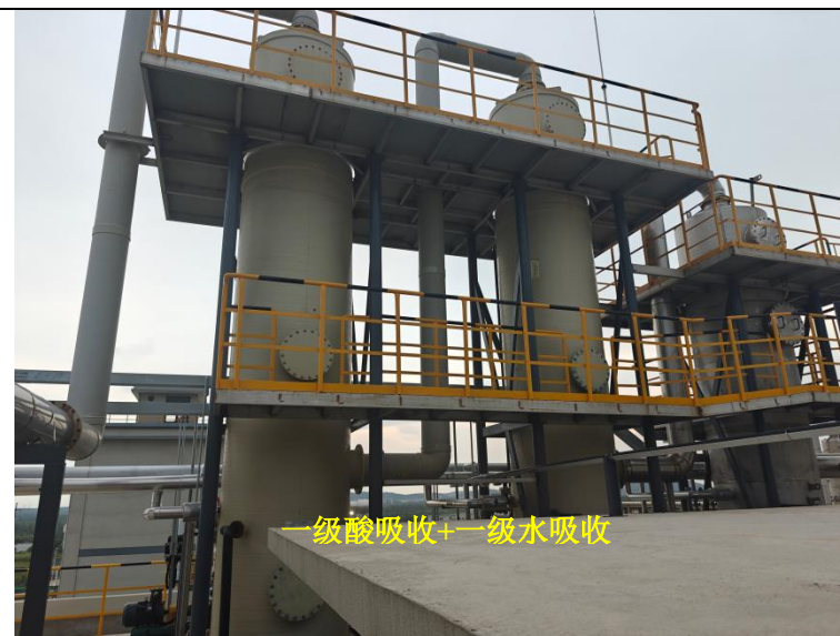
自带旋风布袋除尘器+一级酸吸收+一级水吸收
