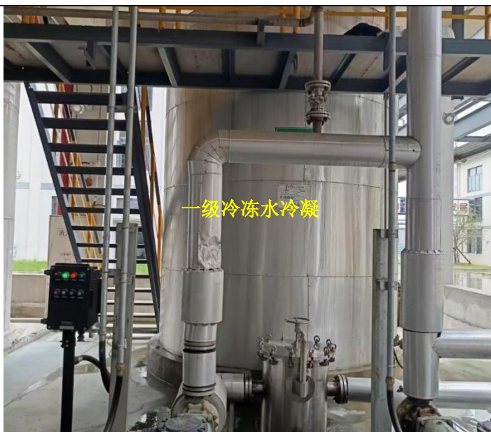
两级水喷淋吸收+两级循环水冷凝（自带）/一级水吸收（自带）+三级稀硫酸吸收+一级冷冻水冷凝+树脂吸附（TA003）
