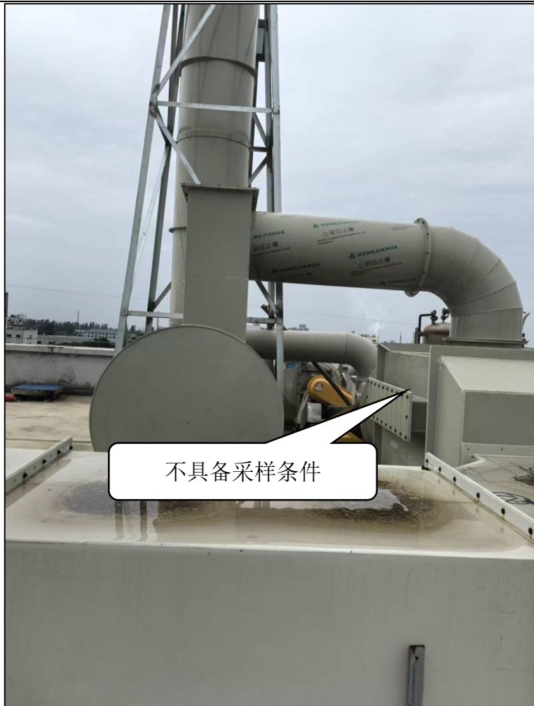
图 3-2 废气进口示意图
