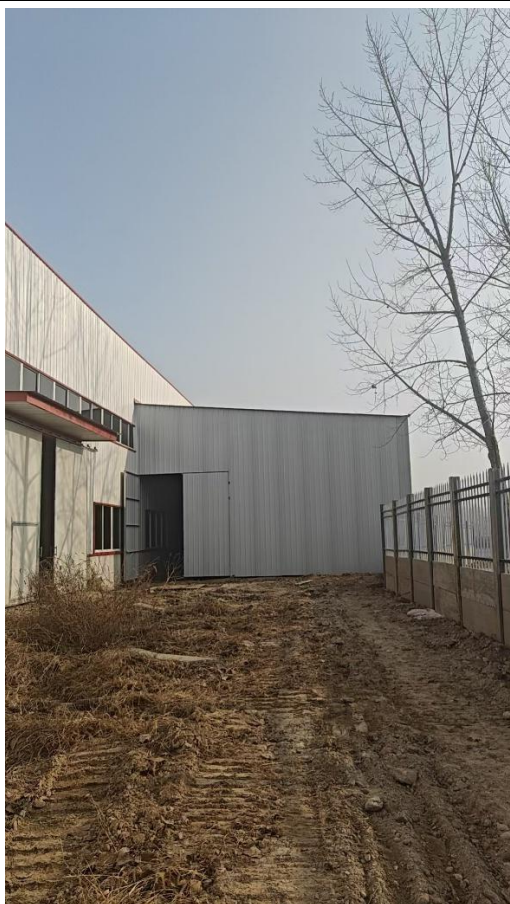
污水处理站（密闭处理）
