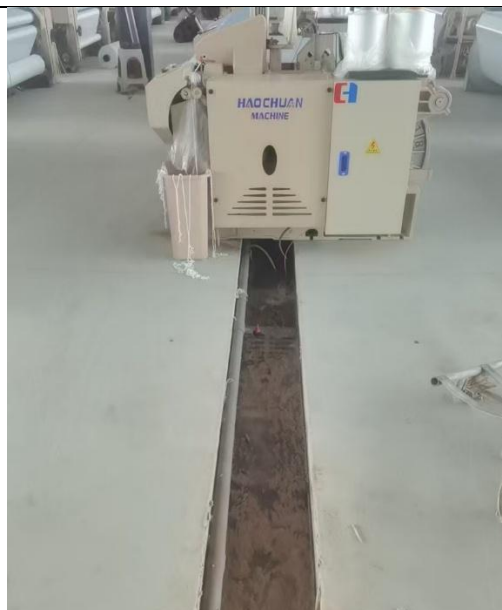
生产车间地面引流沟
