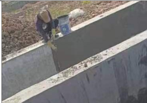
初期雨水池防渗施工
