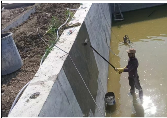
事故池防渗施工
